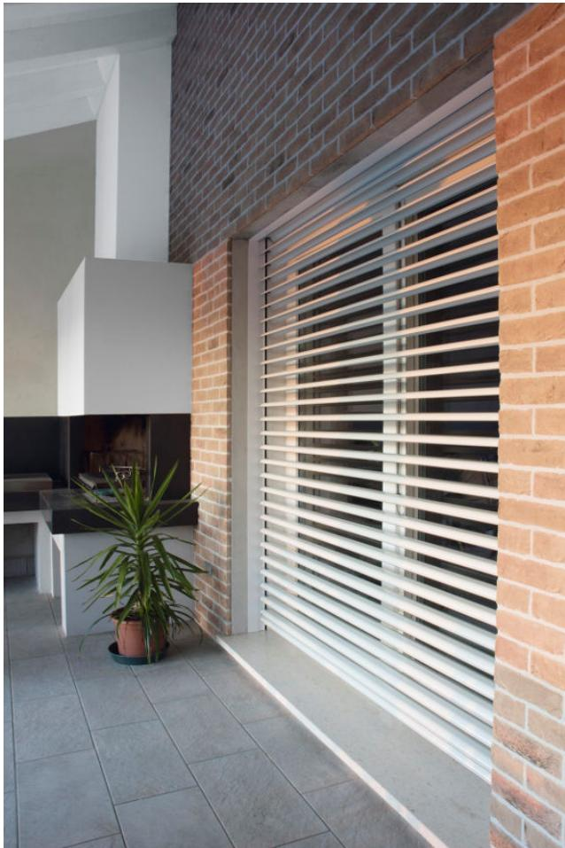
Sistemi di oscuramento con lamelle frangisole orientabili automatizzate e centralizzate (modello SPF "ALPAC" o similari), per la zona giorno: avvolgibili in alluminio estruso coibentati nella zona notte, anch'essi motorizzati. Finitura a smalto in colori chiari; il tutto posto in opera con tutta la ferramenta d'uso in ottone cromato per il sostegno e la chiusura a perfetta tenuta.
